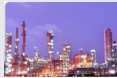
Petroz & Gaz Tesisleri
